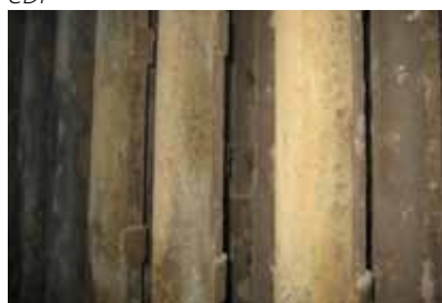
Tuberías de caldera recubiertas por rociado y fusión
