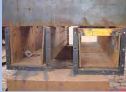
Ductos de transporte cuadrados
