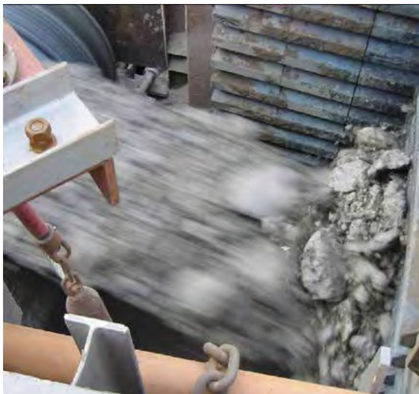
Placa de impacto al final de la banda transportadora
