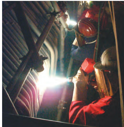
Revestimiento de una Caldera in situ
