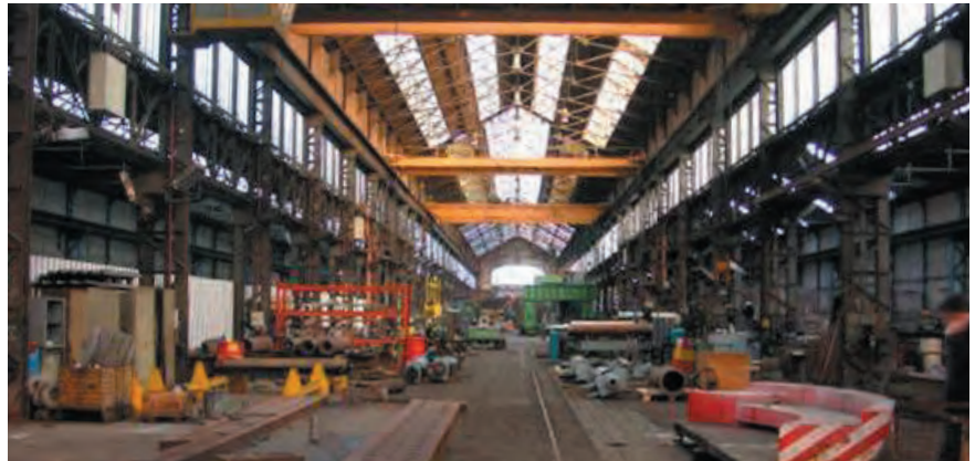
Gran Taller de Servicios CastoLab® para grandes reparaciones, Revestimiento de Caldera in situ
