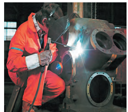
La capacidad de soldar "en posición" hierro fundido "en frío" con Xuper 2240, facilita la reparación de grandes y costosas fundiciones.
