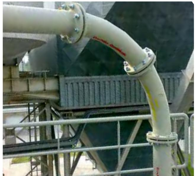
Codos situados por encima de la plataforma, los tubos fabricados con una aleación Nano lleva una inscripción amarilla, mientras que el partido de tipo CastoTube® clásico son de color rojo.
