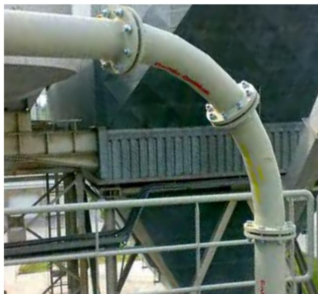
Coudes situés au-dessus de la plate-forme, les tubes fabriqués avec l'alliage Nano porte une inscription jaune alors que la partie de type CastoTube® classique est rouge.
