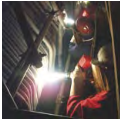
Revêtement de tubes de chaudière sur site
