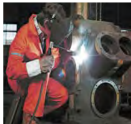
L'aptitude à souder de la fonte "en position" avec la Xuper 2240 facilite la réparation d'une grande pièce en fonte onéreuse et complexe (gain de temps et d'argent).
