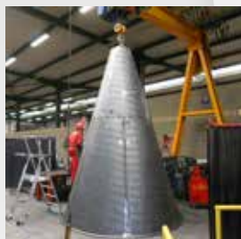
Reparatur des Materialkonus einer Kohlenmühle mit CDP®
