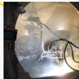
Mahlteiler-Reparatur mit MTC 8338
