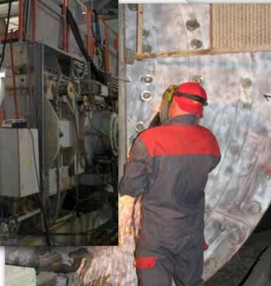
Rissreparatur an einer Kugelmühle
