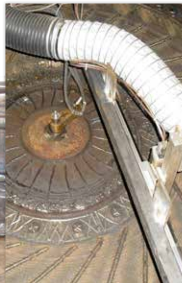
Mahlteller einer Alstom-Kohlenmühle
