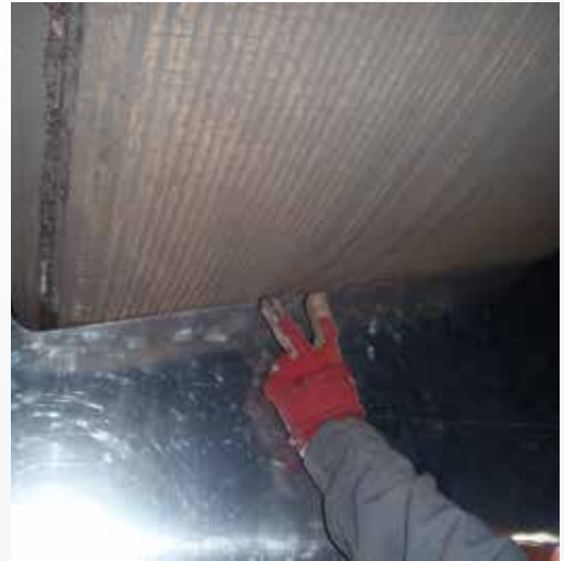
Kontrolle des geschweißten Profils einer Loesche-Mühle zur Klinkermahlung
