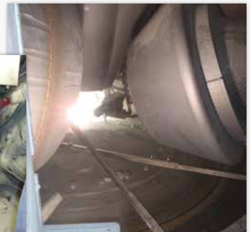
Loesche-Mühle LM 46.2+2, 2 Rollen und Mahlteller gleichzeitig geschweißt
