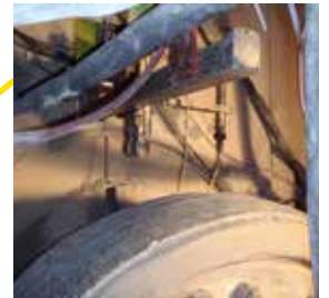
Ремонт роликов с помощью МТС 8338
